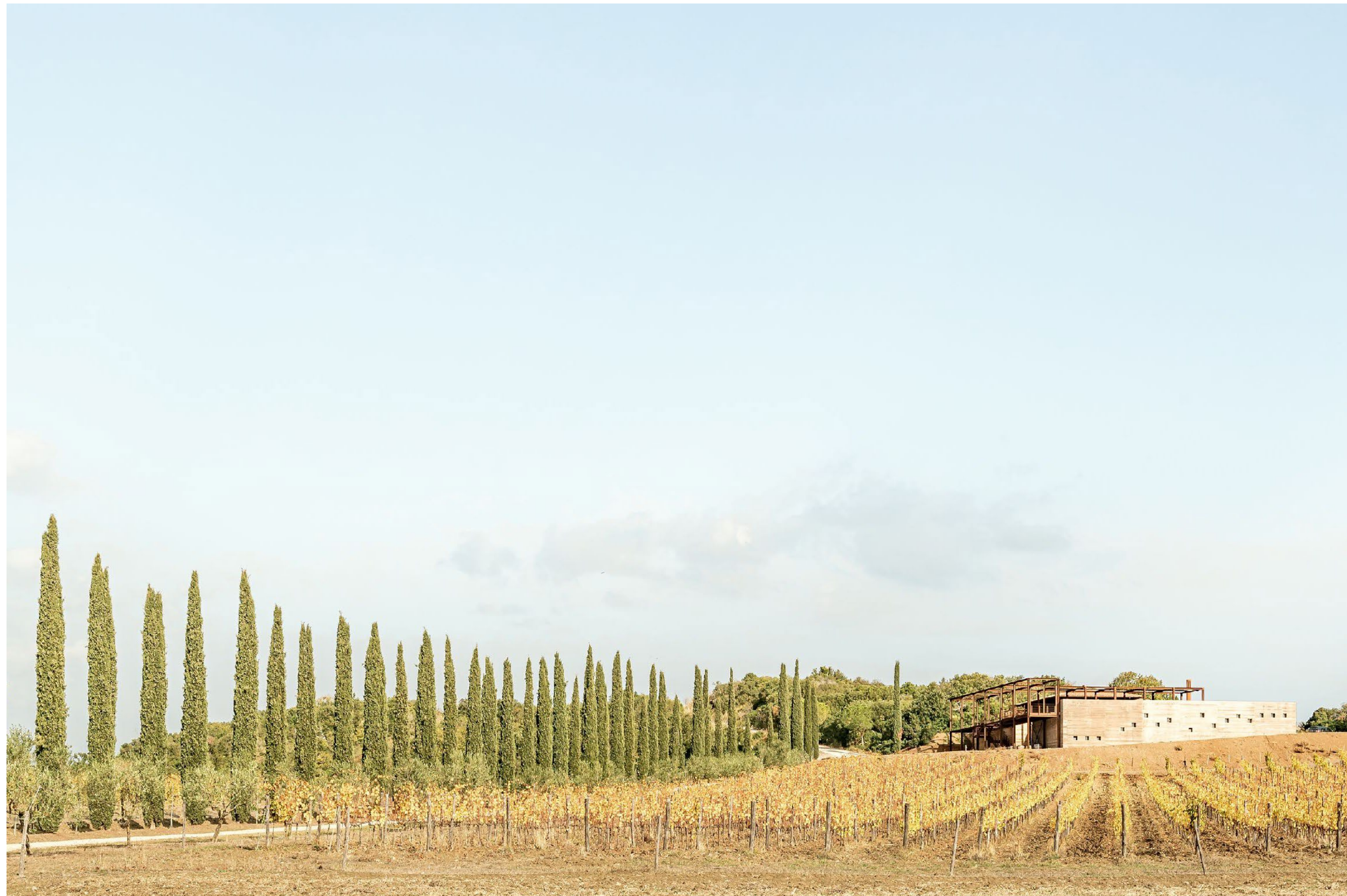
CANTINA CUPANO, Montalcino, Siena 2021 Edoardo Milesi & Archos
