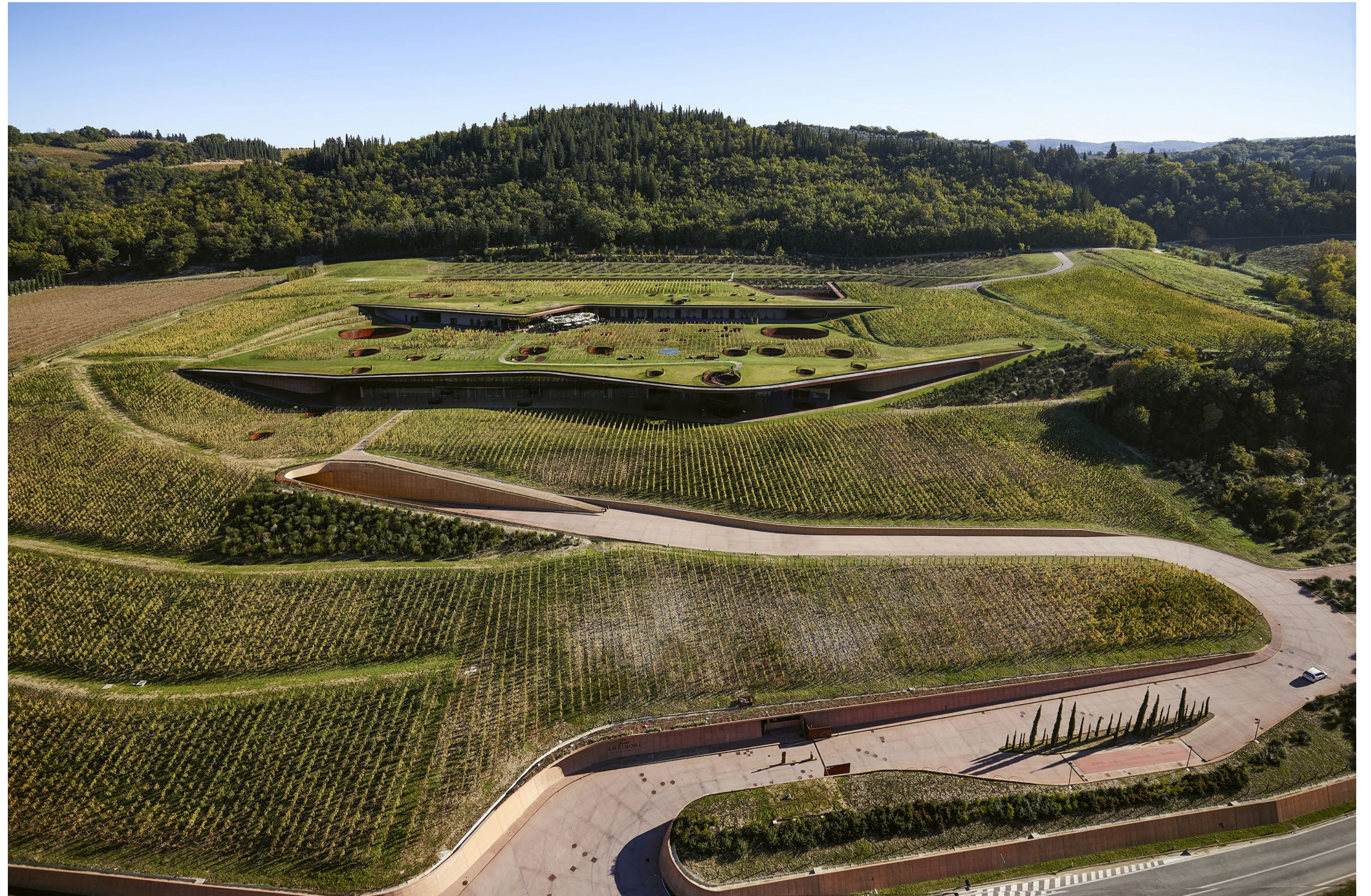
CANTINA ANTINORI, San Casciano Val di Pesa, Firenze 2013 Archea Associati
